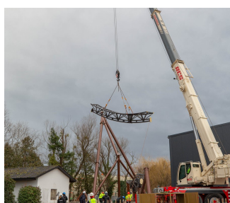
Die erste Schiene schwebt ein, ehe die Montage beginnt.
