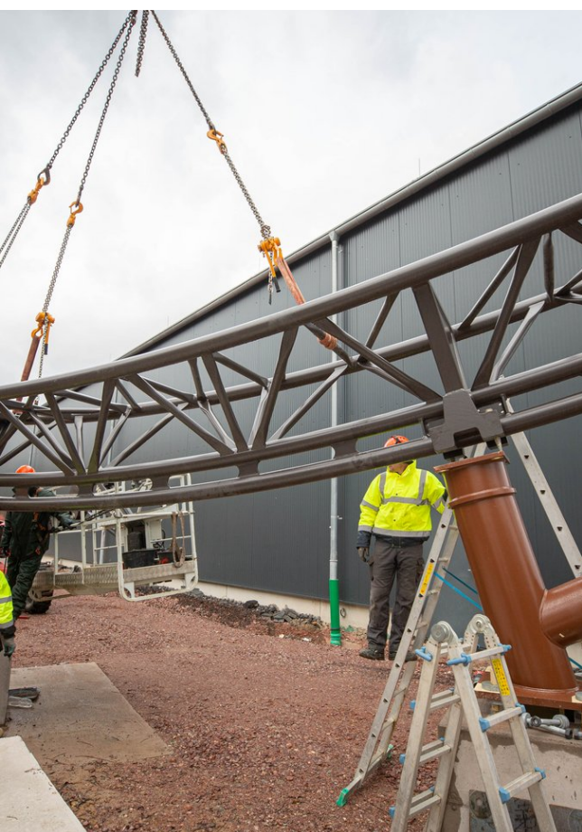
Weiterer Meilenstein: Das erste Schienenelement der neuen Achterbahn im Europa-Park wird montiert, in den nächsten Wochen werden zahlreiche weitere folgen.
