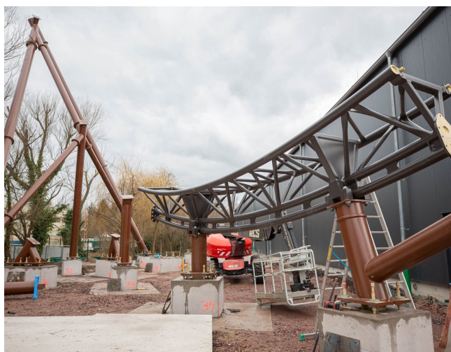
Die erste Schiene ist montiert. Im Hintergrund ist eine weitere, hohe Stütze vorbereitet.
