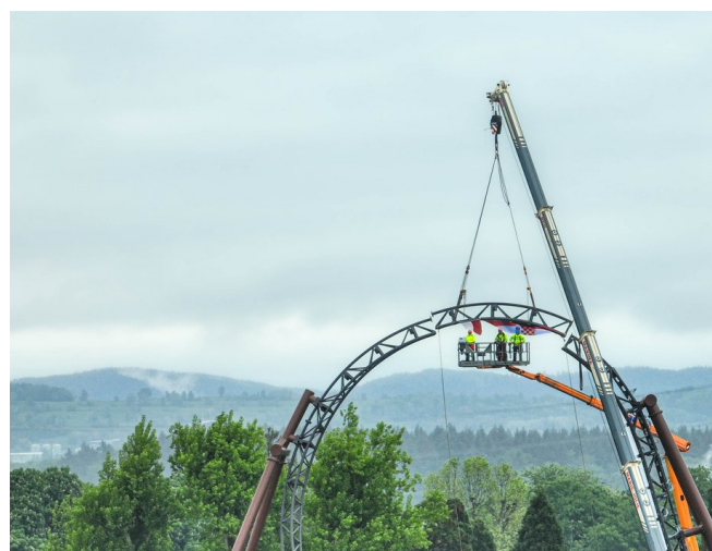
Die Schiene ist 6,71 Meter lang und wiegt 1,9 Tonnen – dabei repräsentieren die Flaggen den deutschen Hersteller MACK Rides, den neuen kroatischen Themenbereich und die polnische Aufbau-Crew von RCS.
