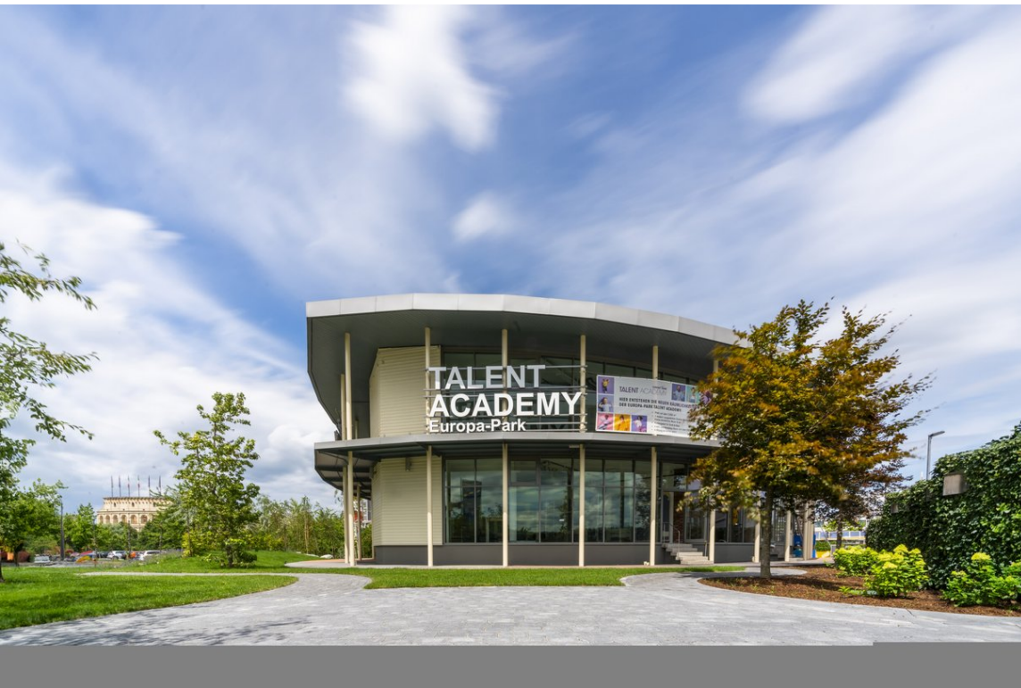
Das neue Gebäude der TALENT ACADEMY
