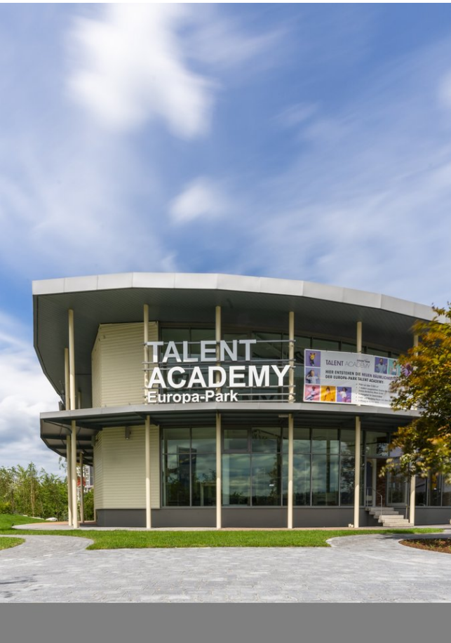
Das neue Gebäude der TALENT ACADEMY
