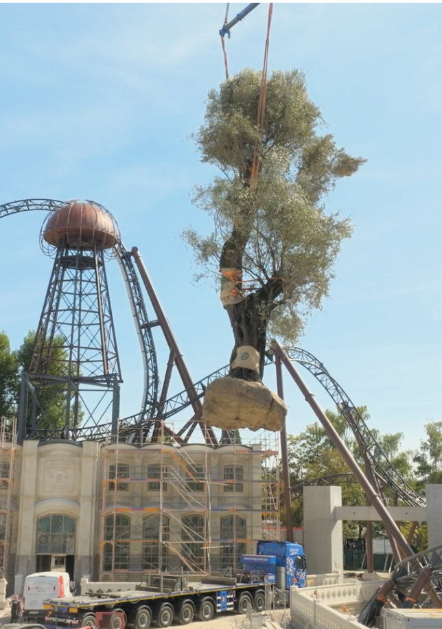
Mit einem Kranwagen wurde der 800 Jahre alte und acht Tonnen schwere Olivenbaum im künftigen Kroatischen Themenbereich verpflanzt
