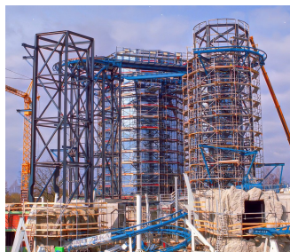
1996/1997 entstehen die ikonischen Türme, die gleichzeitig als Stützen dienen
