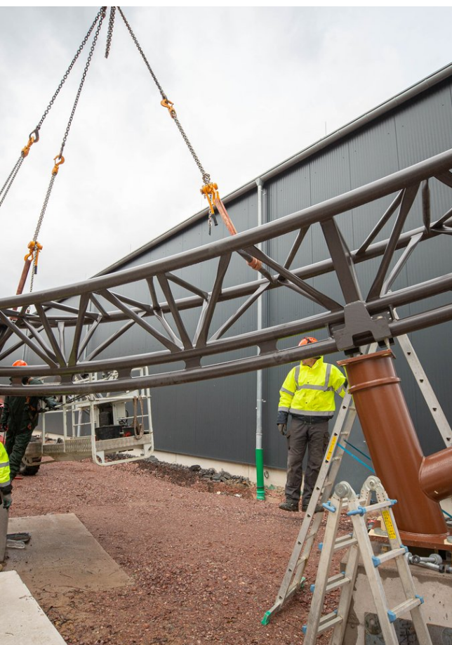
Une nouvelle étape du chantier a été franchie avec la pose du premier rail
