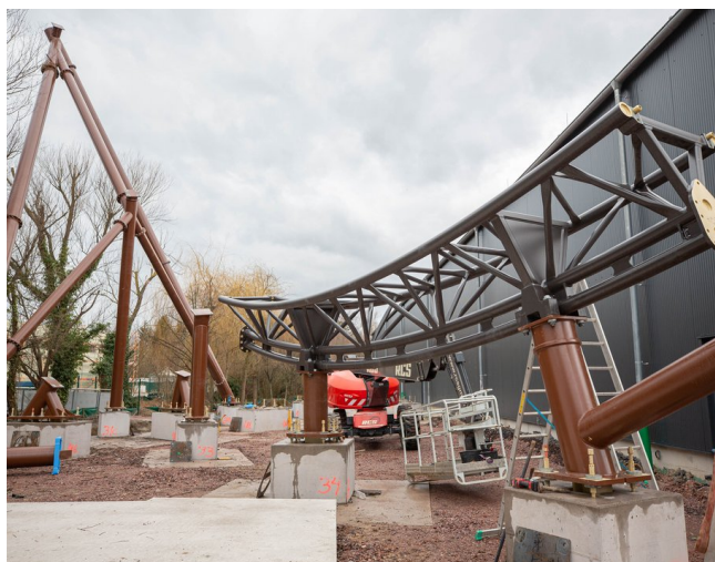
Alors que le premier rail est posé, un nouveau poteau est en cours de montage
