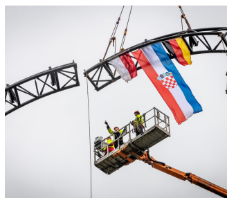
Montage de l'élément de rail n°80, marquant l'achèvement du parcours du nouveau grand huit. Les drapeaux représentent le constructeur allemand MACK Rides, le nouveau quartier thématique croate et l'équipe de montage polonaise de RCS.
